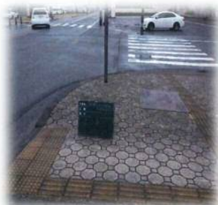
車止めの設置
