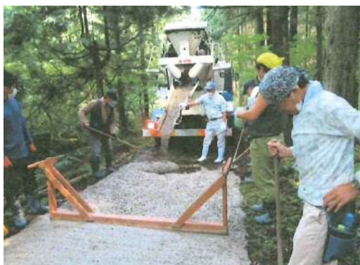
集落による林道維持活動（舗装施工）
