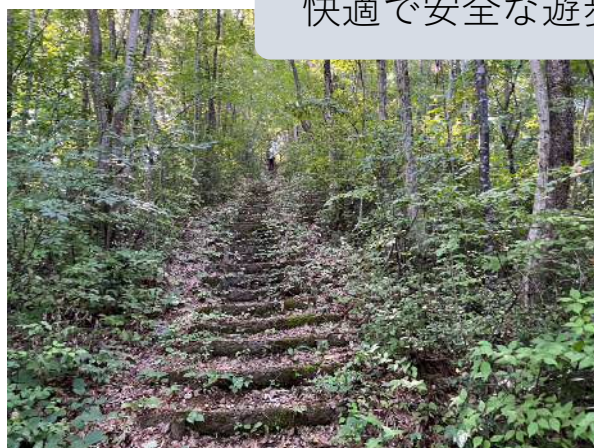
老朽化した階段の改修
