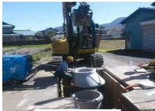
下水道の整備工事の様子
