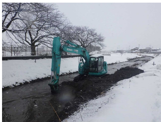
浚渫（堆積土砂の撤去）
