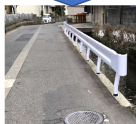
ガードレール設置
