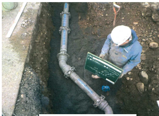
水道管の耐震化工事の様子
