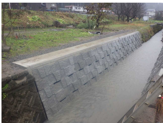
河川改修（護岸の補強）
